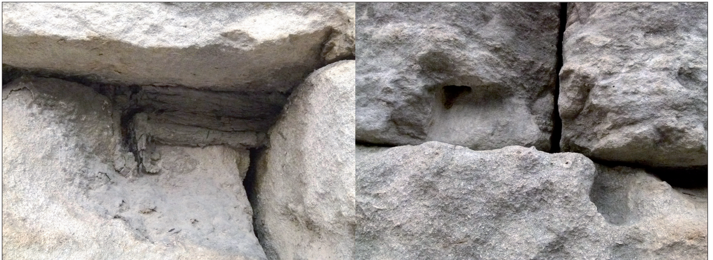
Fig. 6 – À gauche, agrafe en pi et à droite, logements de pince à crochet. Initialement situés au cœur de la maçonnerie, ils sont apparus accidentellement en parement du mur après le démaigrissement des assises supérieures du mur du podium.
