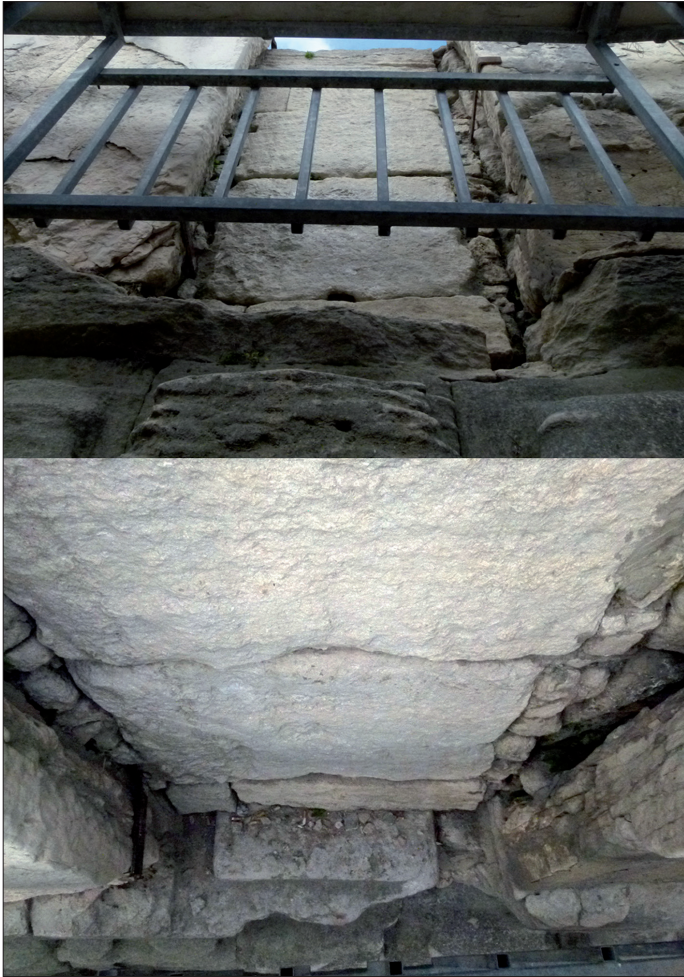
Fig. 10 – Porte bouchée au Nord-Est. Le seuil de la porte avait déjà été taillé mais la porte n'a jamais pu fonctionner.
