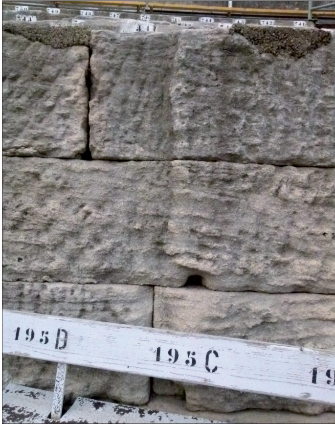
Fig. 6 – À gauche, agrafe en pi et à droite, logements de pince à crochet. Initialement situés au cœur de la maçonnerie, ils sont apparus accidentellement en parement du mur après le démaigrissement des assises supérieures du mur du podium.
