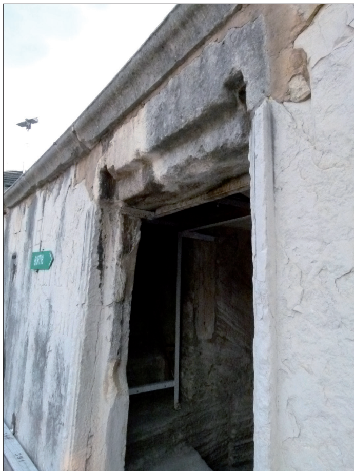
Fig. 8 – La porte de la tribune ouest. Les piédroits moulurés sont taillés dès l'origine dans les plaques inscrites. En revanche, le linteau n'est pas réalisé dans le même type de pierre et sa pose a nécessité la retaile des deux plaques latérales. Il peut s'agir d'une restauration antique ou moderne. En arrière-plan, on distingue l'un des escaliers de la tribune qui a été démaigri lors de la mise en place des plaques contre le mur du podium .
