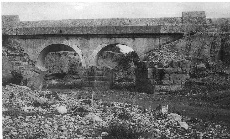
Fig. 3. Les dépôts de la très basse terrasse holocène historique principale. Sur la rive droite de l'oued bou Djbib, ils recouvrent les piles du pont de l'aqueduc d'Hadrien réutilisées ensuite pour la conduite contemporaine.
