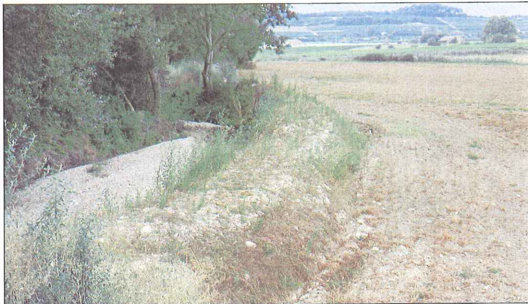
Photo n°13 : Les sous affluents eux-mêmes ont été fréquemment recalibrés et endi- gués, supprimant le rôle écreteur de cru de leur lit majeur (affluent de l'Eze - Vaucluse)
