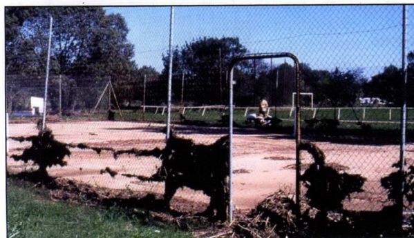
Photo 1 - Dépôts de la crue de 2002 sur le court de tennis d'Attuech (lit majeur du Gardon d'Anduze).
