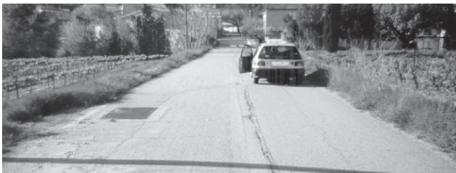
FIGURE 6. Lit majeur et basse terrasse pléistocène de l'Ouvèze à Roaix. Major bed and Pleistocene lower terrace of the Ouvèze at Roaix.
