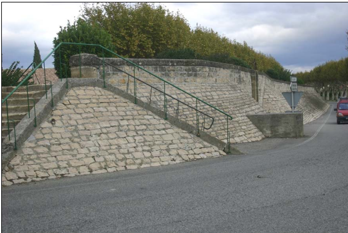
Photo 43 - Digue de Caderousse (Vaucluse). [Cliché : J.L. BALLAIS, 2010]
