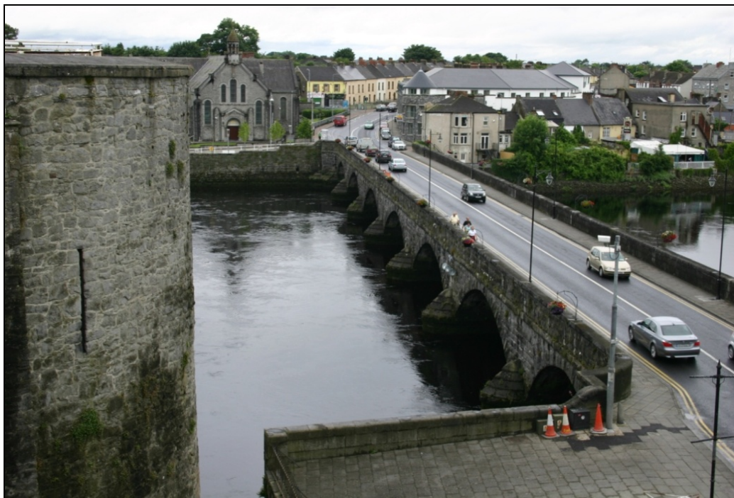
Photo 62 - Thomond Bridge sur le Shannon à Limerick (Irlande).
