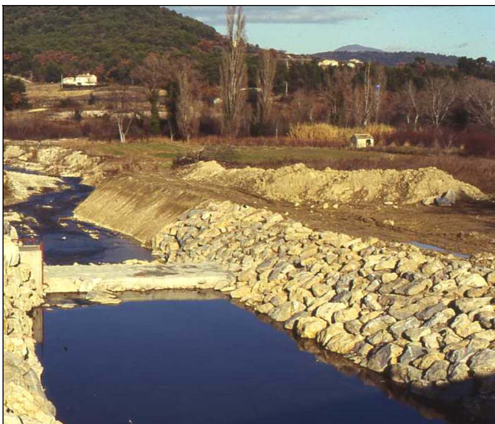
Photo 78 - Remodelage et endiguement du Groseau au Crestet (Vaucluse) après la crue de 1992. [Cliché : J.L. BALLAIS, 1994]
