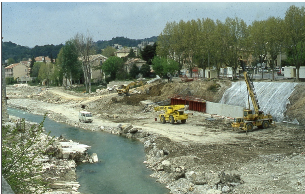
Photo 66 - Aménagement des lits de l'Ouvèze à Vaison-la-Romaine (Vaucluse) après la crue du 22 septembre 1992. [Cliché : J.L. BALLAIS, 1995]
