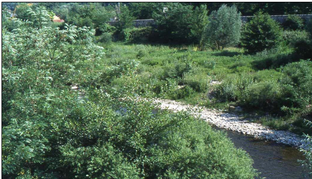
Photo 48 - La Cèze endiguée à Bessèges (Gard).
