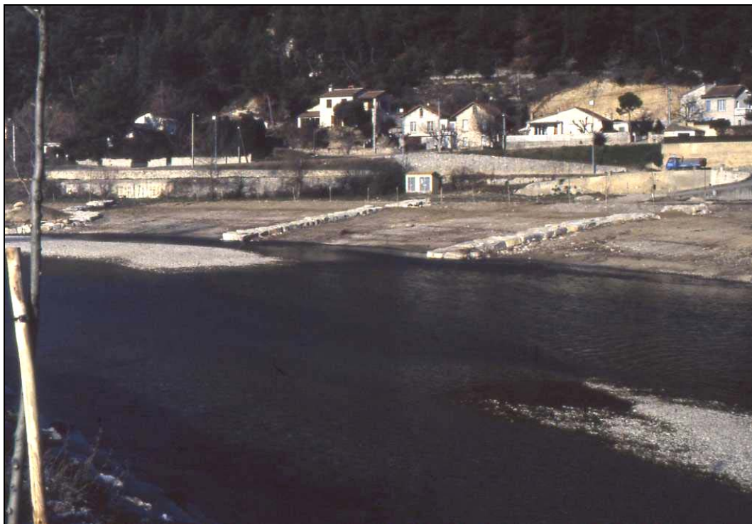
Photo 77 - Aménagement de l'Ouvèze à Vaison-la-Romaine (Vaucluse) après la crue de 1992. [Cliché : J.L. BALLAIS, 1998]
