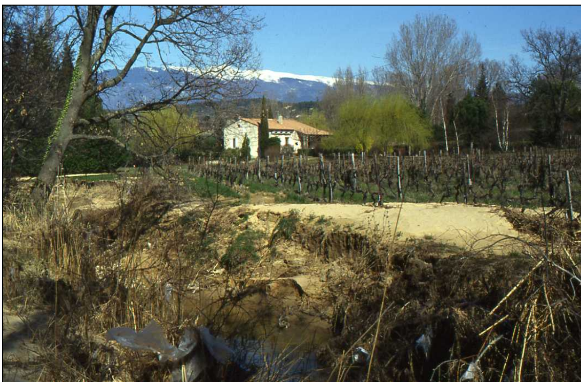
Photo 18 - "Jet de rive" sur le lit majeur de l'Auzon à Mazan (Vaucluse) lors de la crue de 1994. [Cliché : J.L. BALLAIS, 1994]
