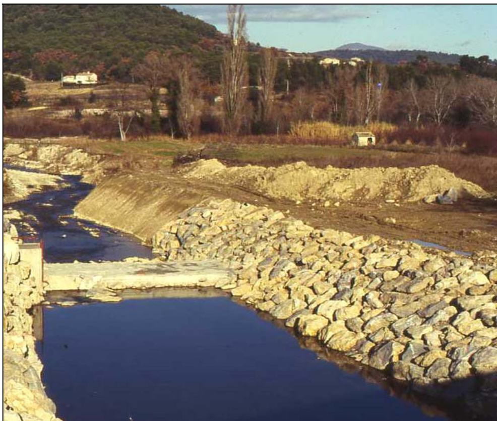
**Photo 78 - Remodelage et endiguement du Groseau au Crestet (Vaucluse)
