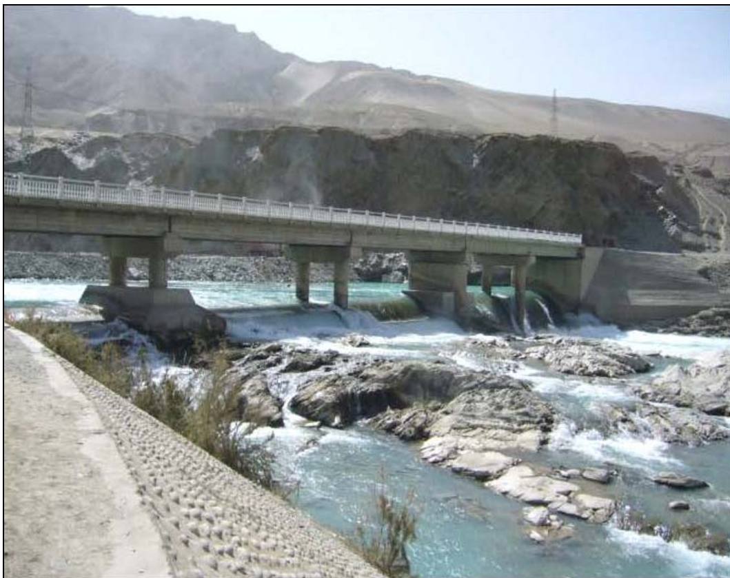
Photo 2 - Le pont d'Ulugata. Le lit mineur où affleure la roche en place et la rive droite endiguée. [cliché : M. WULAMU, 2008]
