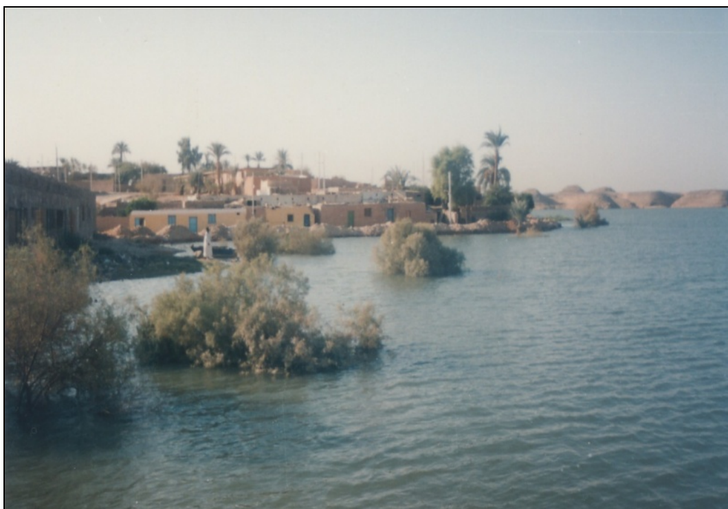
Photo 8 - Un village isolé par l'inondation à 150 km au sud d'Assouan.
