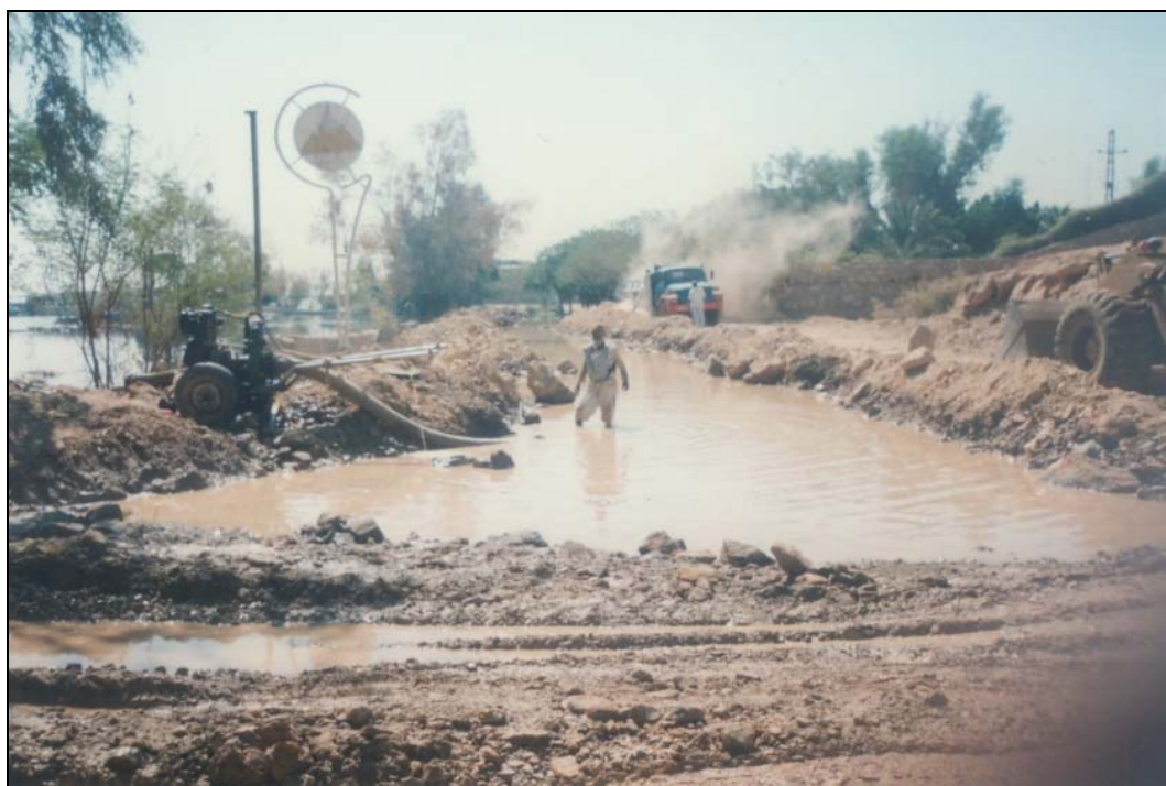
Photo 10 - Route de l'usine de conserves de poissons inondée.
