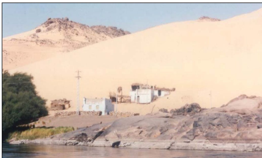
Photo 11 - Déplacement de sable vers les habitations à Gharb Assouan.
