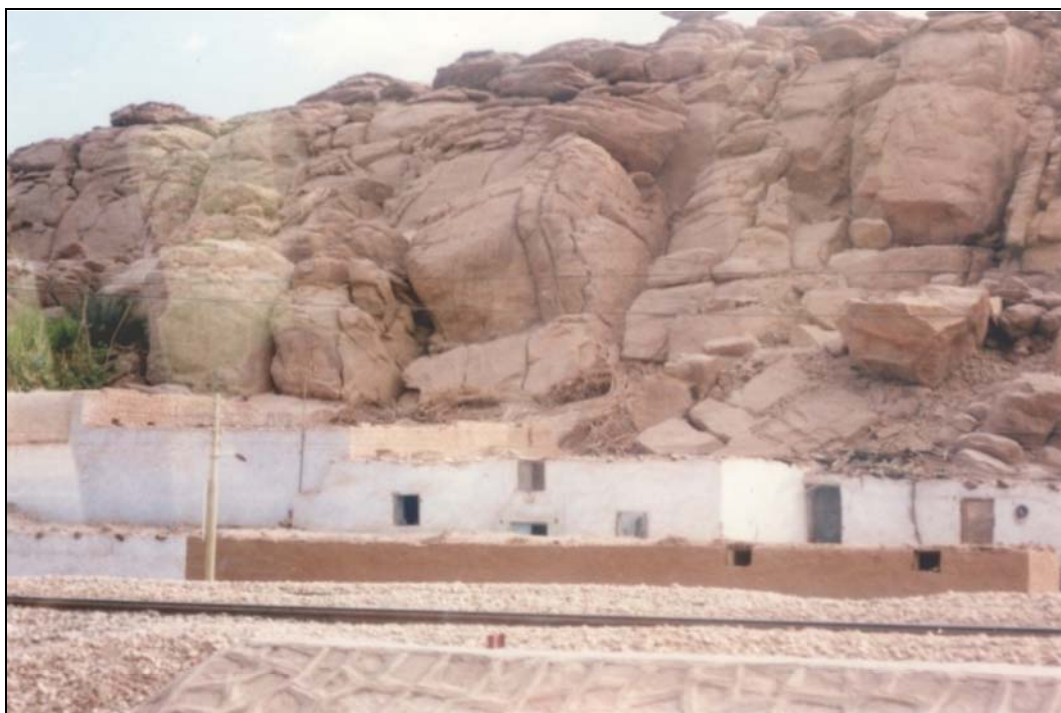
Photo 4 - Fissurations verticales et horizontales sur le versant du talus et les masses tombées sur le versant d'Abou er Rishe.
