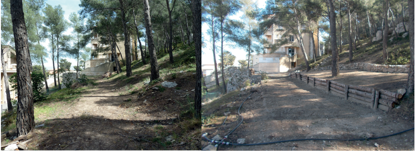
Fig. 2. — Aménagement de la zone de production du Lycée des Calanques avant (à gauche) et après travaux (à droite). Crédit photo : Paul Monsara.
