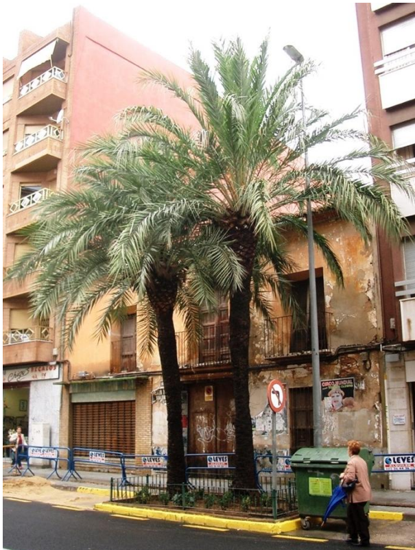
Fig.9 : Une maison ancienne d'agriculteur, rue de l'Ermitage à Torrente, aire métropolitaine de Valence
