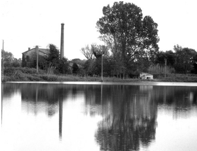
Figure 3 : La « machine de Montcalm », pompe à vapeur destinée à alimenter le domaine en eau depuis le petit Rhône (1892). Cliché de l'auteur.
