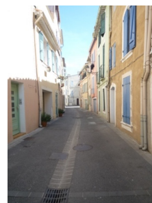
Figure 33. Façades restaurées dans le centre ancien
