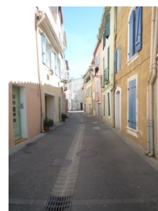
Figure 33. Façades restaurées dans le centre ancien
