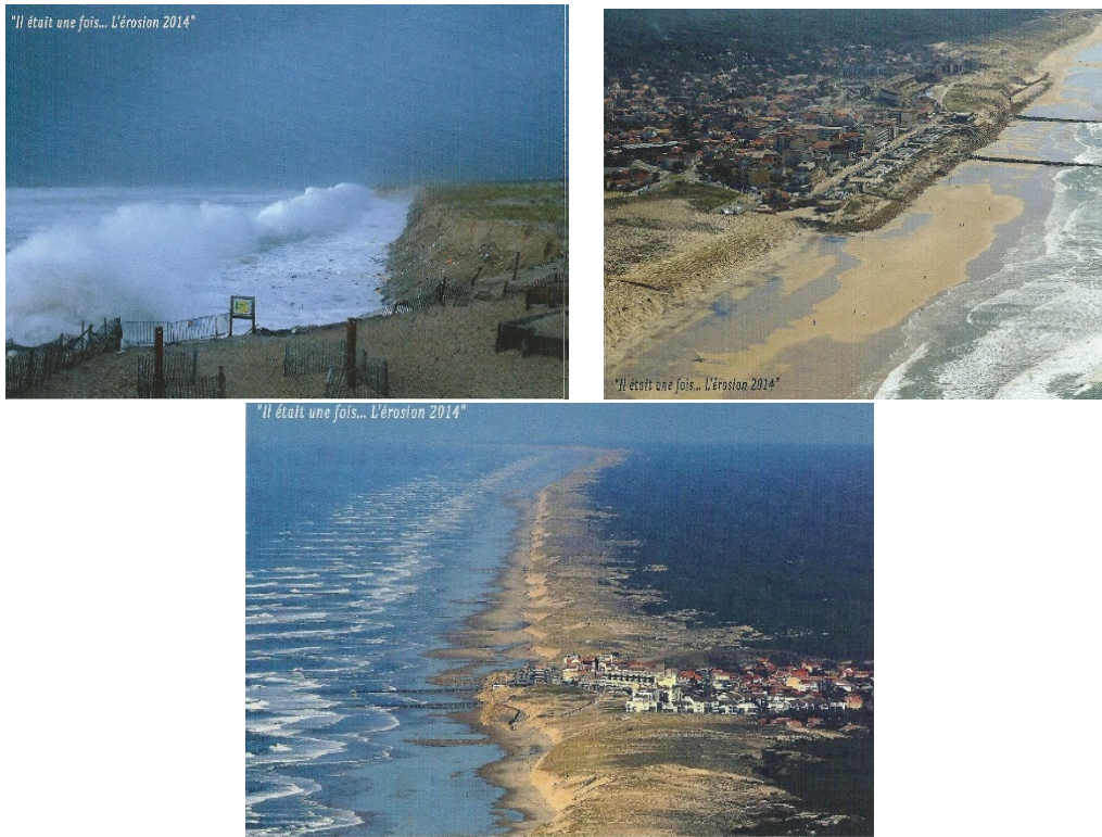
Figure 90. Photos de la maison de la glisse plage nord, du front de mer et du trait de côte à Lacanau (mars 2014)
