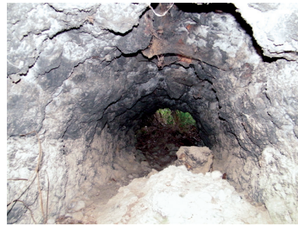
Figure 1. Vestiges actuels non sécurisés de la cheminée rampante de l'usine de soude proche du col de la calanque de Sormiou
