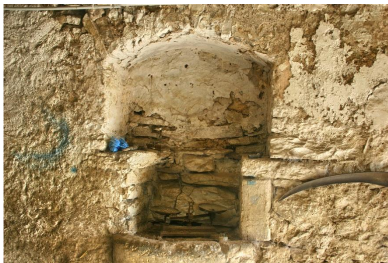
Photo 8 – Probable Grange Saint Xavier en 2016 – Évier et fenêtre bouchés (Cliché Jean-Louis Ballais)
