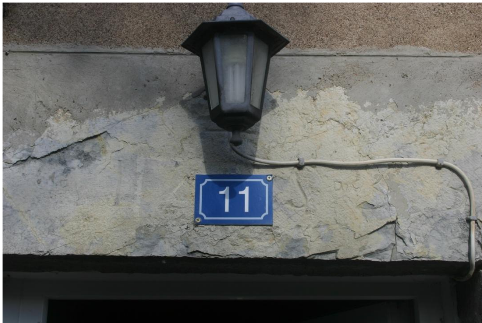
Photo 5 – Linteau du bâtiment de 1735 en 2016 (Cliché Jean-Louis Ballais)
