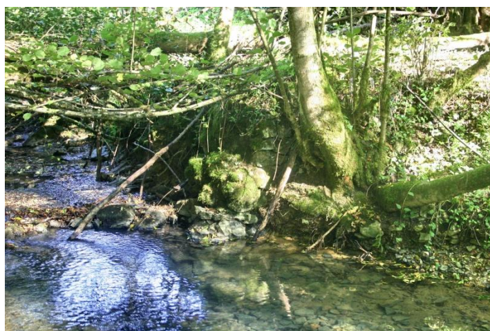
Photo 3 - Grange d'Hiram – culée de pont en 2016 (Cliché Jean-Louis Ballais)
