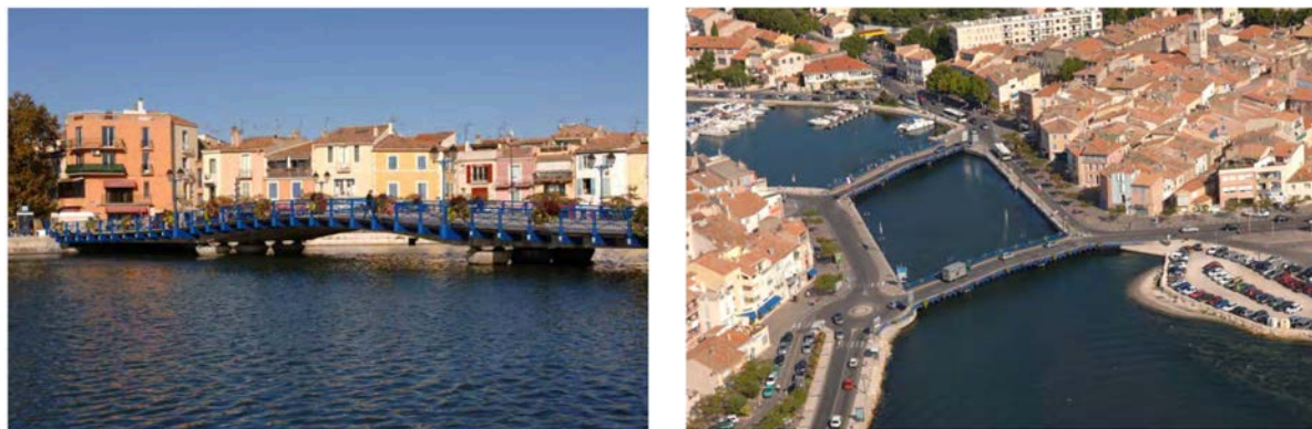
Figure 12. La requalification des ponts bleus du centre-ville (Canal de Bausseque), 2001
