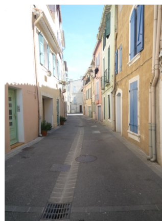
Figure 11. Façades restaurées dans le centre ancien de Martigues
