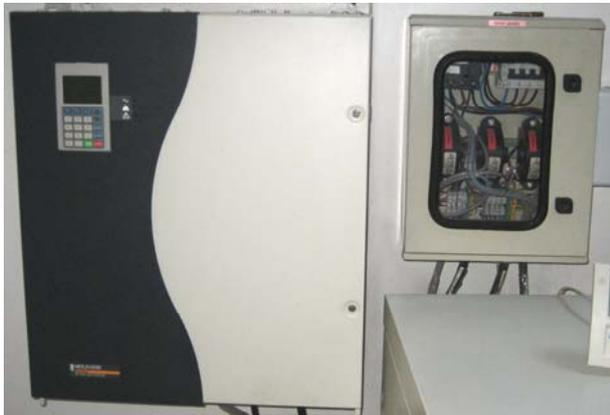
**Figure 7 :** Compensateur actif SineWave (MGE UPS SYSTEMS™) de calibre 20 A (à gauche). Transformateurs d'intensité pour les mesures et les apports des courants de compensation (à droite).
