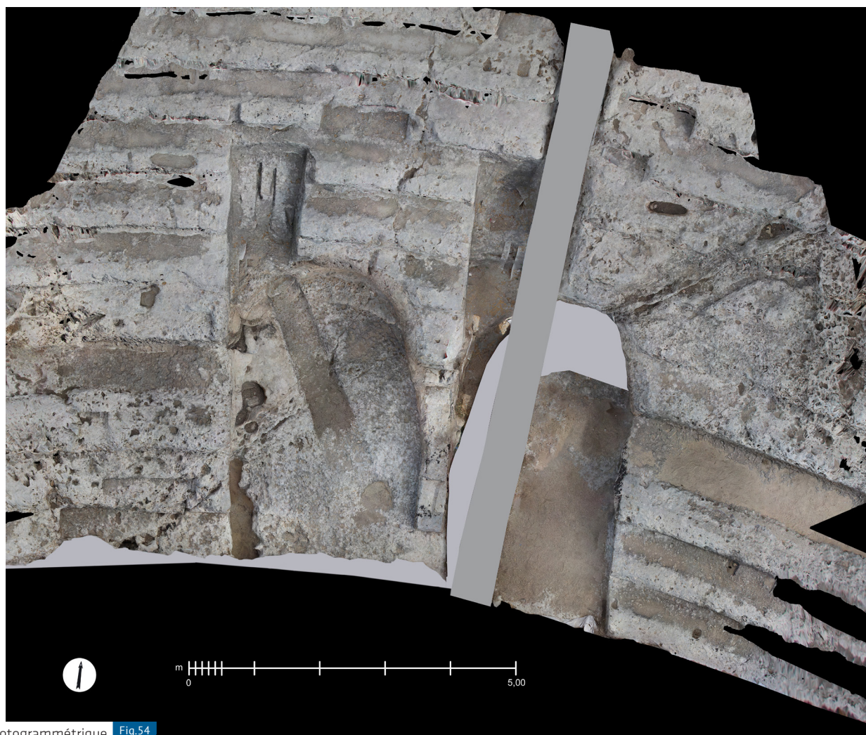
Relevé photogrammétrique du moulin Primo Fig.54
