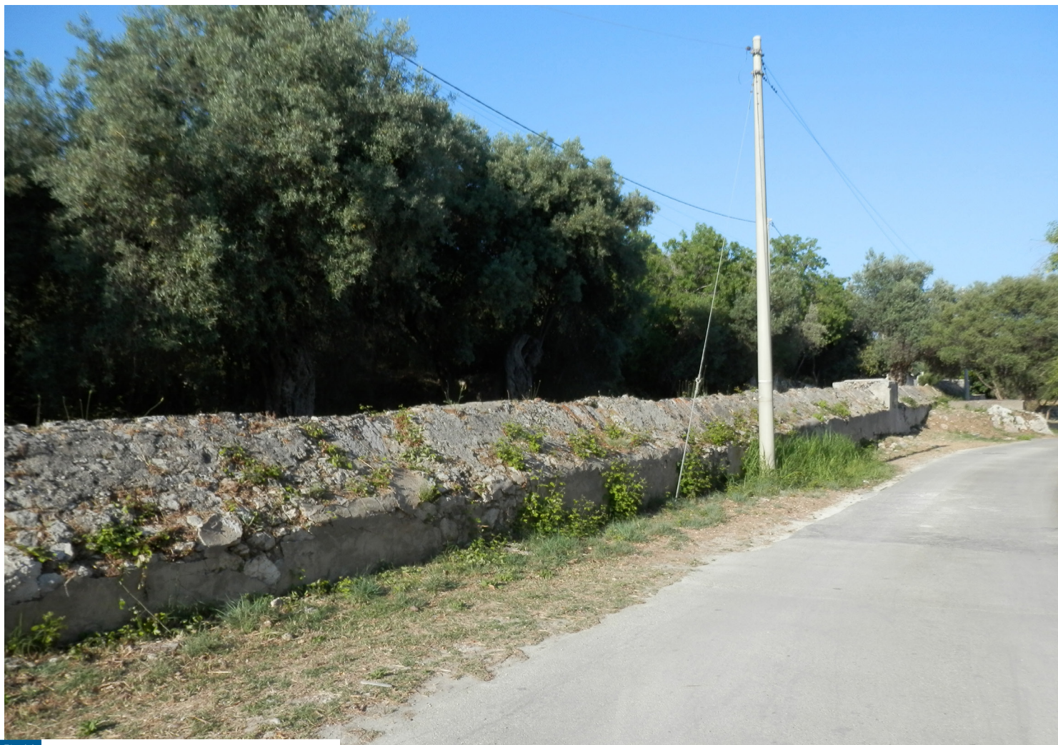
Fig.14 Galerie moderne en bâtière, contrada Sinerchia
