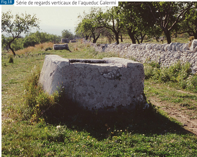
Fig.18 Série de regards verticaux de l'aqueduc Galermi
