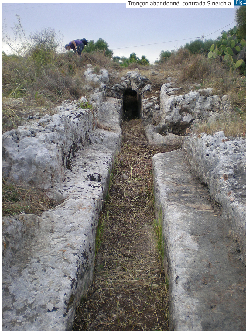
Tronçon abandonné, contrada Sinerchia Fig.13
