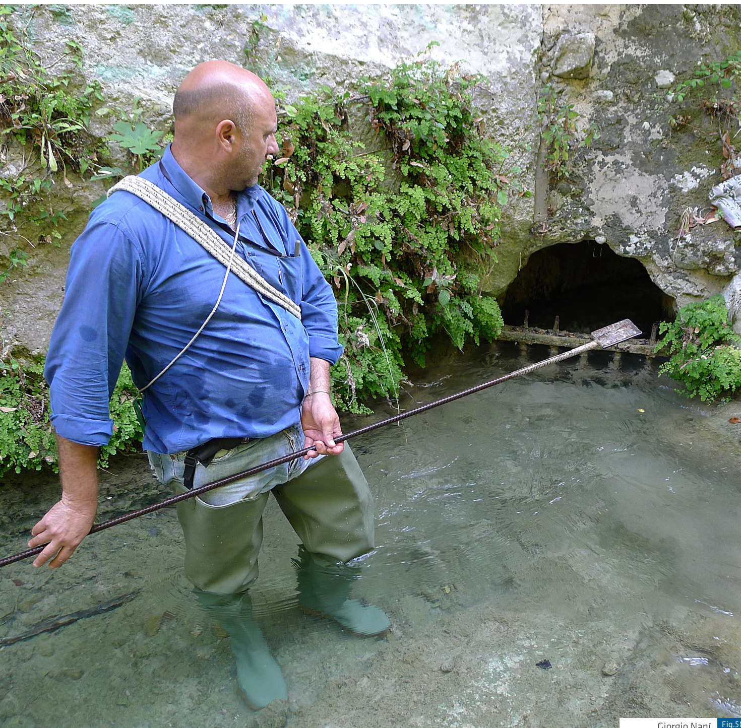
Giorgio Naní, Fig.58 agent du Génie Civil, nettoyant la grille du captage de la Bottigliera
