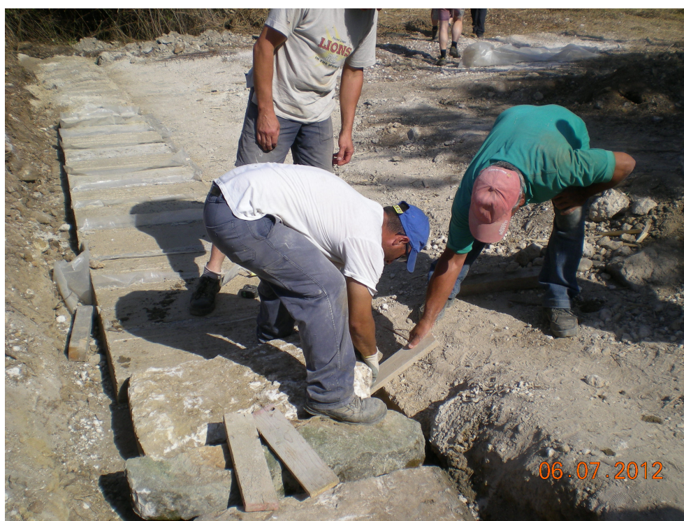
Figure 5. Irrigants réparant le canal après un glissement de terrain
