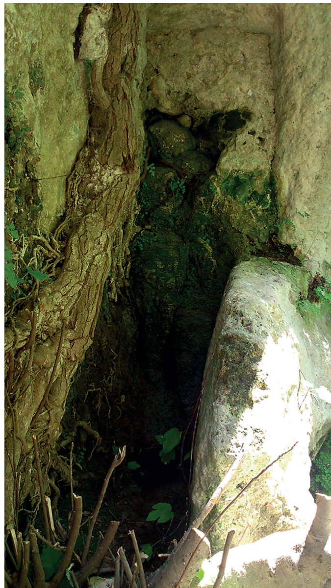
Fig. 14 – Bouchage de la galerie antérieure (© Mission HydroSyra).
