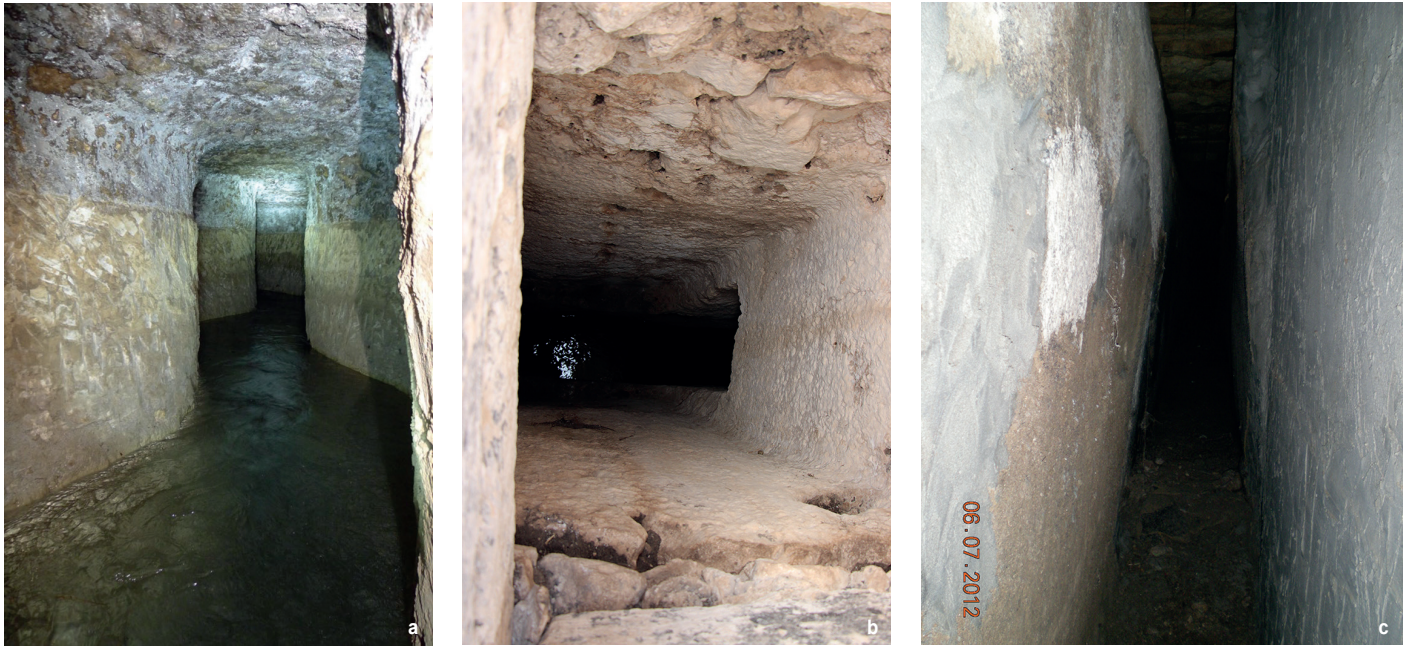
Fig. 8 a, b, c – Typologie de la conduite : les 3 exemples de galerie (© Mission HydroSyra).
