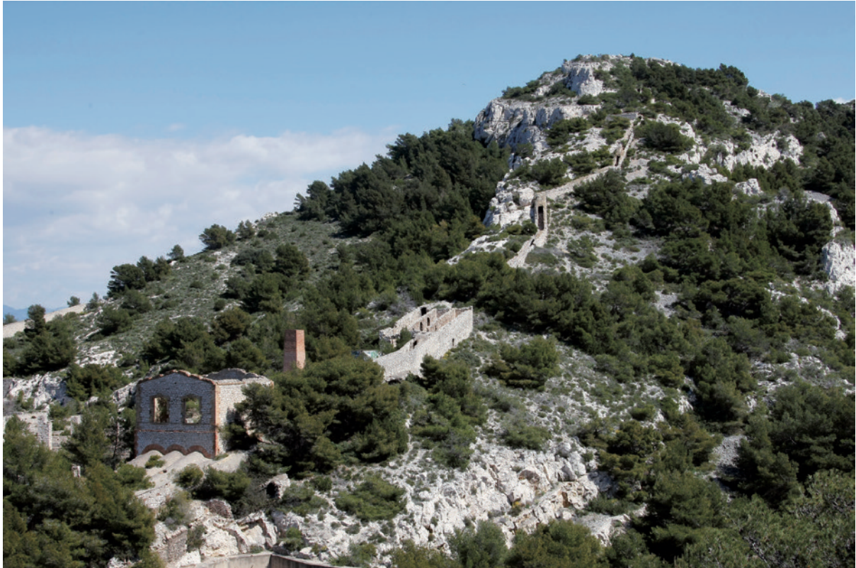
Vestiges de l'usine de plomb de la calanque de l'Escalette. © Claude Paris
