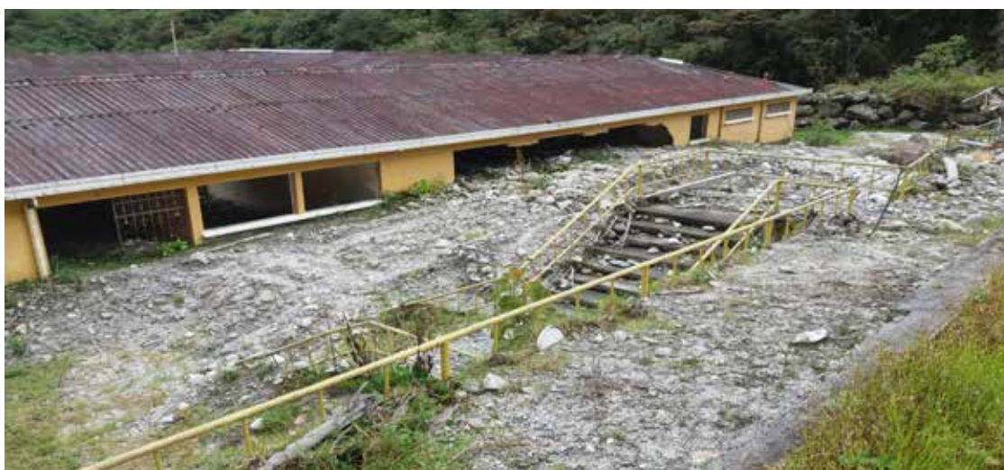
Figura 32. Daños producidos en una escuela durante la riada de febrero de 2018 en el Valle de Zongo.
