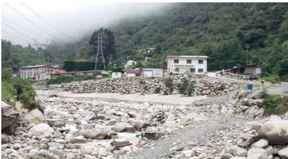
Figura 35. Central hidroeléctrica Cuticucho en Valle de Zongo, 2020.
