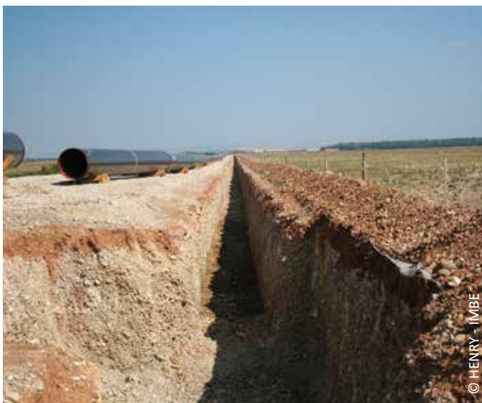
Régilage de la terre végétale sur géotextile en prévision de la restauration du sol des coussouls après installation d'une canalisation enterrée
