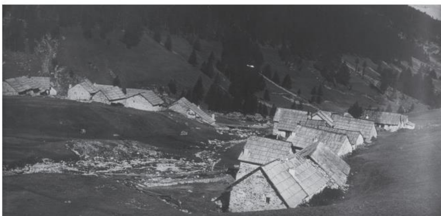
Fig. 12 - Villard-Saint-Pancrace (années 1910-1920). Les chalets groupés des Ayes. Cliché Ph. Arbos.
