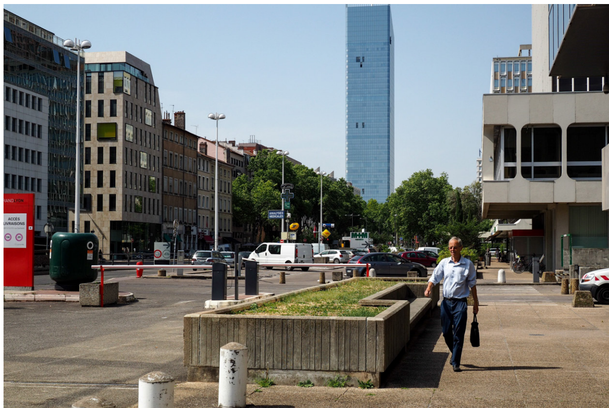
Figure 195 : La partie traitée de la rue Garibaldi (ici en fond) contraste avec le caractère extrêmement minéral de certains espaces autour de la Part-Dieu, et qui feront ici l'objet de la deuxième tranche de ce projet dont la livraison est prévue pour fin 2017 (cliché : Benoit Romeyer).
