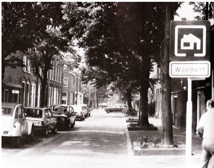
Figure 54 : Photographie d'un aménagement de type woonerf à Delft. La plupart des différents éléments évoqués dans la Figure 53 s'y retrouvent : l'entrée marquée (au moins par une signalisation), la disposition relativement irrégulière de stationnements par ailleurs bien délimités, les ruptures visuelles, les trottoirs absents ou abaissés et les différences dans les revêtements de sols [Appleyard, 1981 : 250].
